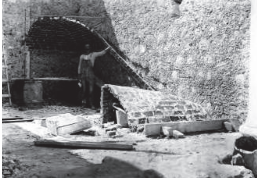
Base de la escalera de mármol del Palacio Cantón Fotografía Col. Arq. Ramón Riancho G. Cantón
