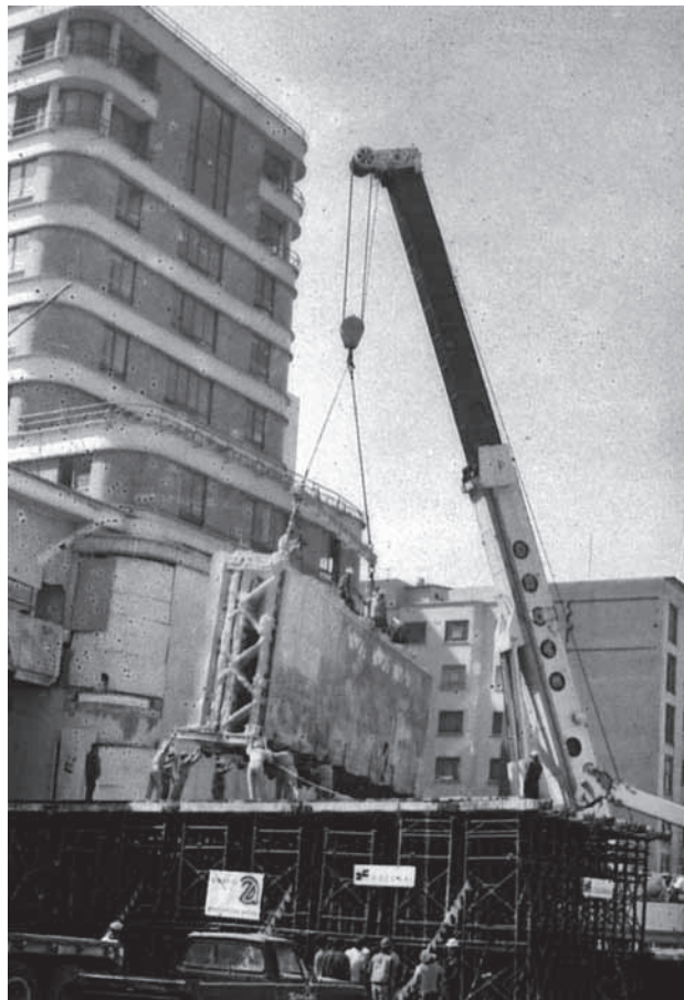
Una vez fuera del recinto, la pluma se levanta y gira para ubicar el mural, con toda su estructura de protección, sobre una plataforma móvil que lo conducirá a su nueva sede en la Plaza de la Solidaridad Fotografía Tomás Zurian
