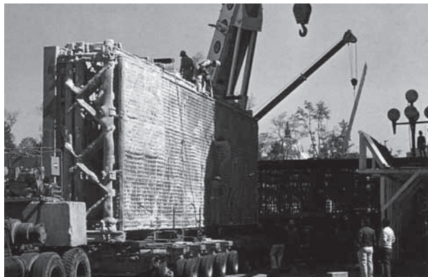
La pluma concluye su labor. La estructura metálica de la parte posterior es la gran rampa, construida ex profeso para deslizar y sacar en su totalidad el mural del hotel a la calle y de este modo ser recibido por la grúa Fotografía Tomás Zurian
