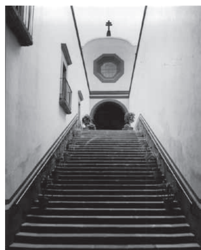
Escalera construida en 1905 por el obispo Ignacio Montes de Oca para conectar la capilla de Aranzazú y retornarla al uso religioso Fotografía MRP-INAH
