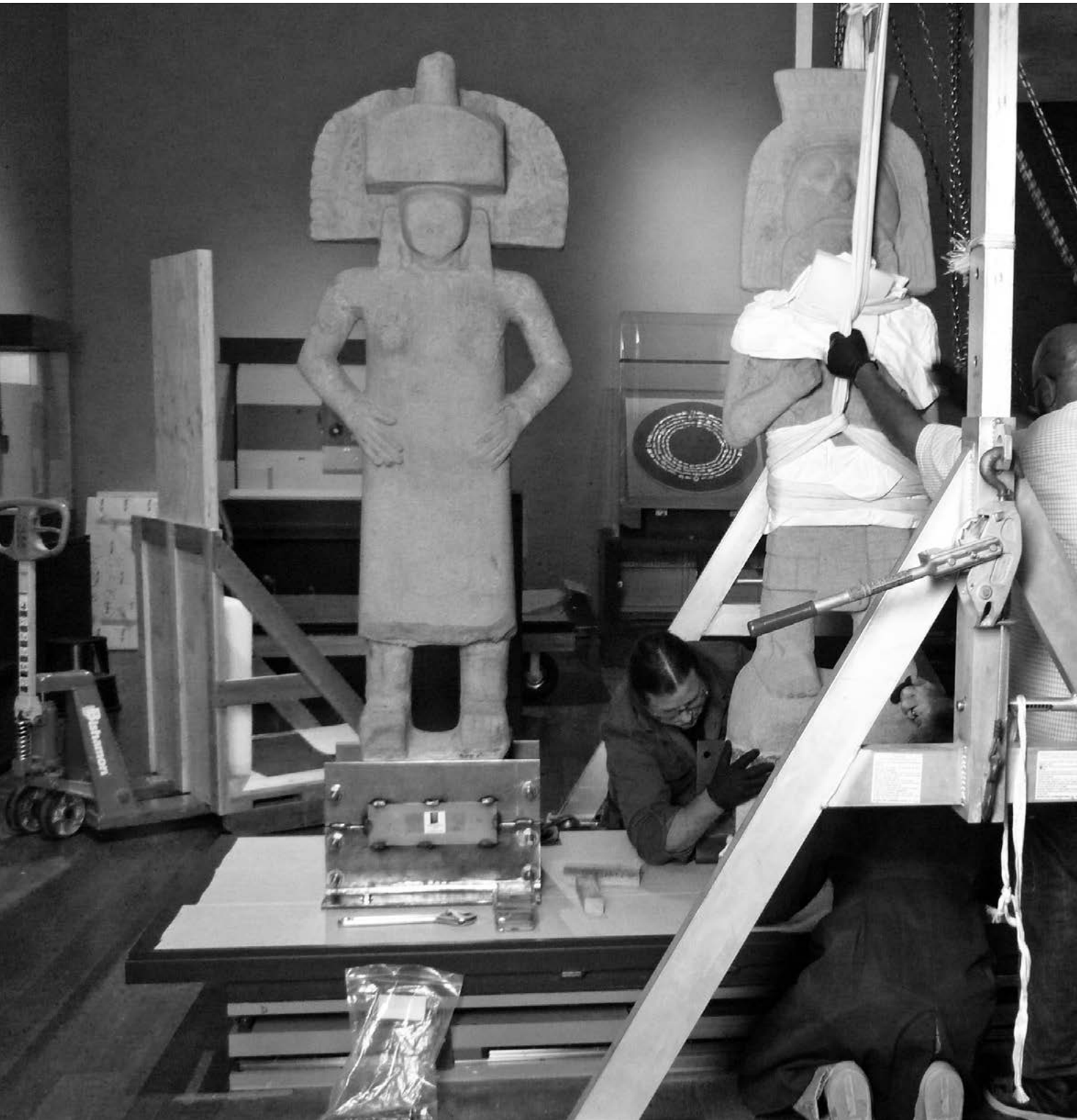
Figura 10 Colocación de las esculturas huastecas en bases antisísmicas, realizadas en el Getty Museum para la muestra Golden Kingdoms: Luxury and Legacy in the Ancient Americas Fotografía © Priscila Medina Tejadilla, CNME
