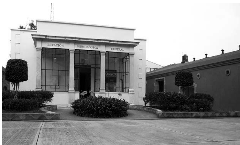
Fachada de la Oficina de la Estación Central de la Red Sismológica Nacional Fotografía © Manuel A. Bravo
