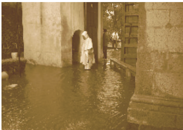
Mal funcionamiento del drenaje
