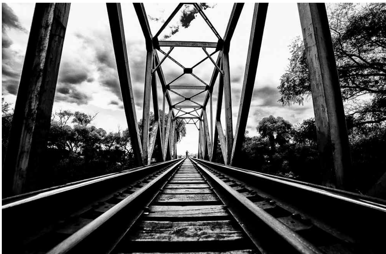
El llamado familiarmente “Puente de hierro” en Acámbaro. Fotografía © Fernando Ávila.
