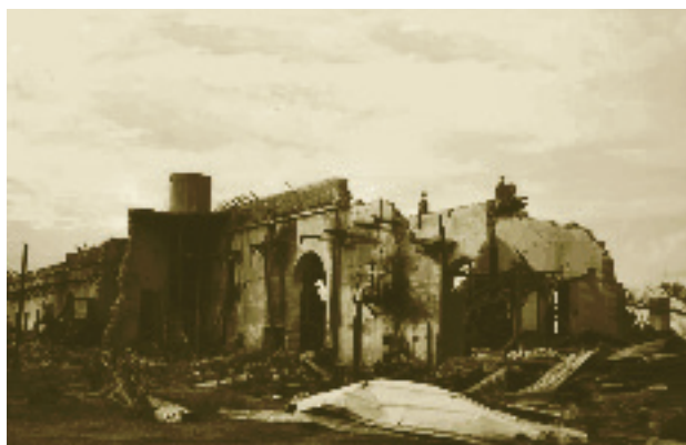
Daños en monumentos históricos
