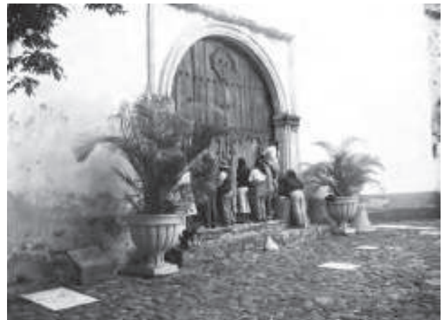
Eliminación de barniz en la puerta de acceso al templo, Santo Domingo Oaxtepec (septiembre de 2009)
