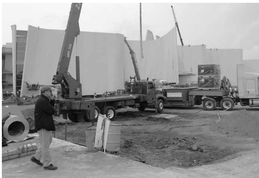
Construcción del Museo Internacional del Barroco, Puebla de Zaragoza, Puebla, ca. 2015.
