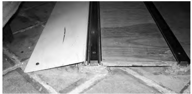
Anclaje de estructuras auxiliares
