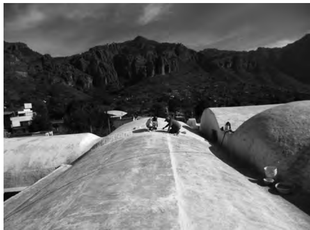
Preparación de las cubiertas para la impermeabilización
