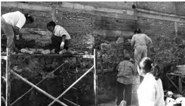
Reposición de barda atrial, San Guillermo Totolapan (noviembre de 2009)
