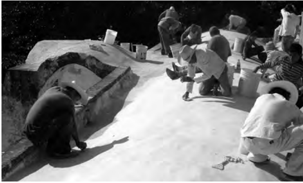
Aplicación de brujido en las bóvedas de San Antonio de Padua, Atlacholaya (octubre de 2011)
