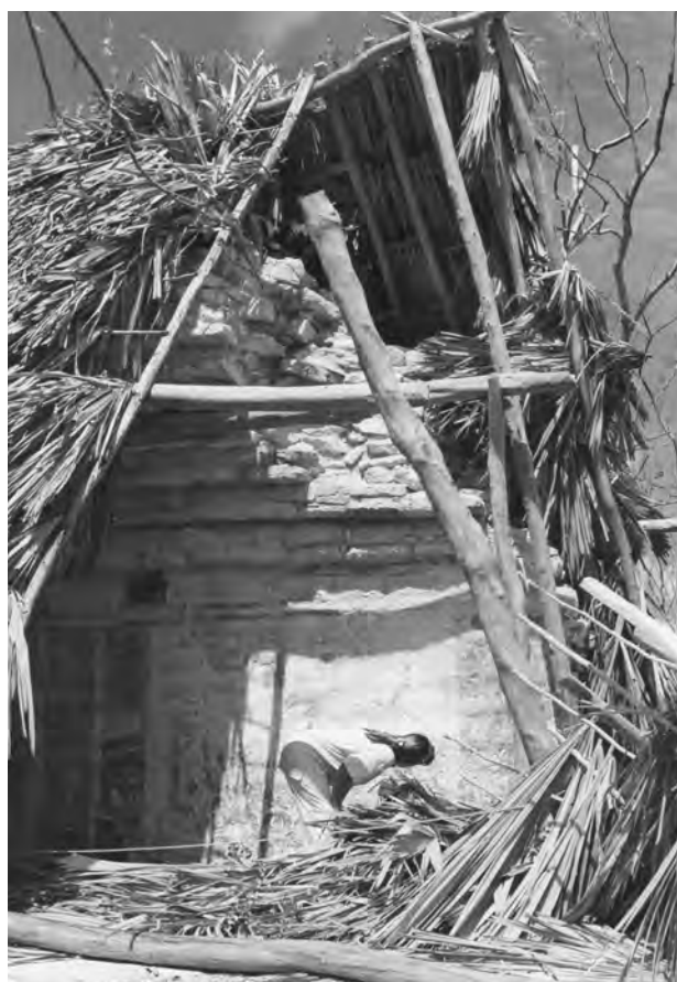
Izquierda y derecha Xel-há: estructura 86 tras el paso del huracán Roxane (1995)
