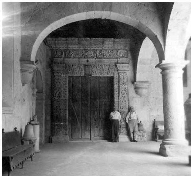
Arriba Obras para el traslado de una portada del siglo xvi desde Alhóndiga 6 hasta el museo Abajo Benítez y Farías junto a la portada de Alhóndiga 6, una vez empotrada (1944)
