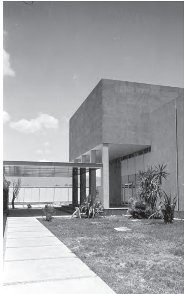
Locales comerciales construidos en los márgenes de los estacionamientos de las puertas 1, 2, 3 y 5, como parte del proyecto 1959-1964
