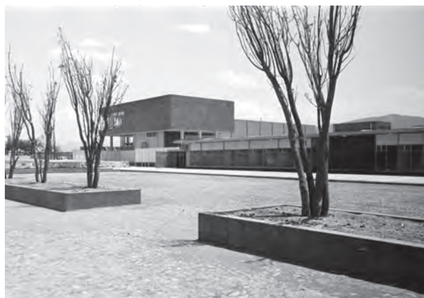
Locales comerciales construidos en los márgenes de los estacionamientos de las puertas 1, 2, 3 y 5, como parte del proyecto 1959-1964
