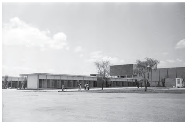
Locales comerciales construidos en los márgenes de los estacionamientos de las puertas 1, 2, 3 y 5, como parte del proyecto 1959-1964
