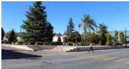
Plaza en 2019, antes del inicio de los trabajos de recuperación. Fotografía: Dirección de Obras Públicas del Municipio de Hidalgo del Parral, 2019.
