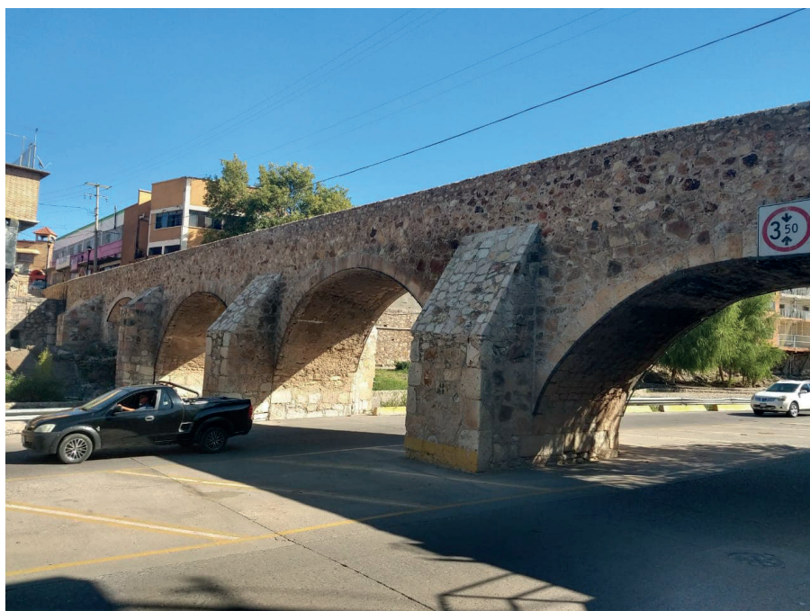
Figura 3. Restauración y reconstrucción de puente calicanto. Fuente: http://www.codigol3parral.com/wp-content/uploads/2019/10/72899495_762943677485782_3736437246178361344_n.jpg
