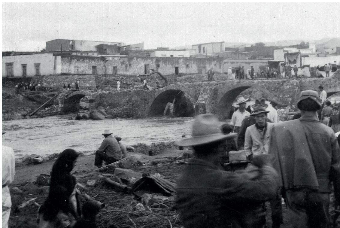
Figura 1. Puente calicanto dañado por inundación, año de 1944, Hidalgo del Parral. Fuente: Fototeca INAH Chihuahua.
