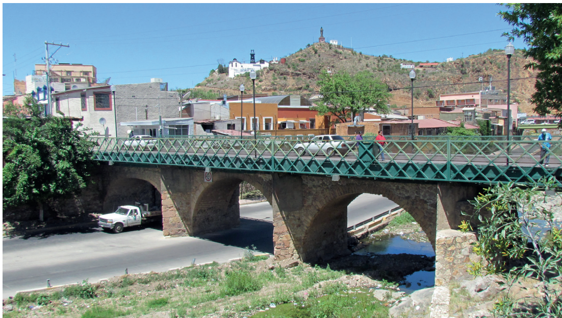
Figura 2. Puente calicanto con refuerzo estructural de concreto para tránsito vehicular. 2014. Fuente: Archivo Técnico de la Sección de Monumentos Históricos.
