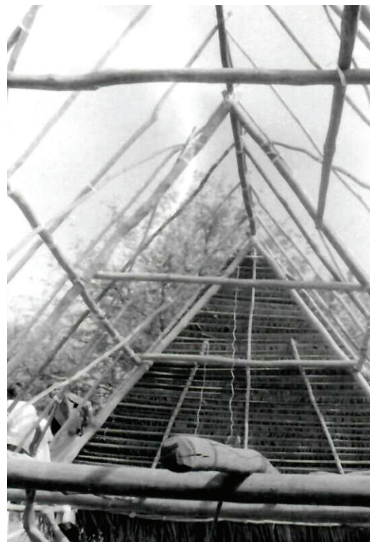
Construcción de una casa mazateca. Se observa la viga principal de la casa (donde se posa el espíritu de los difuntos recientes). Fotografía Esperanza Penagos, Isla Málzaga, Oaxaca, México 1997.
