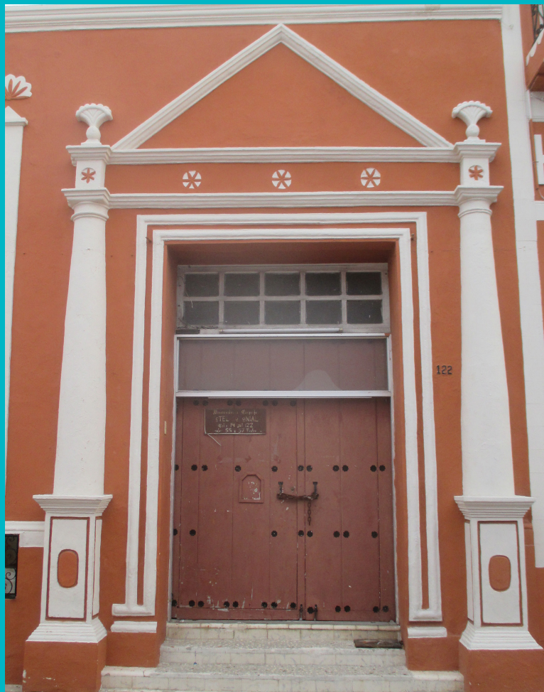
Figura 2. Fachada de la Casa de Teniente de Rey sobre la Calle 14.
