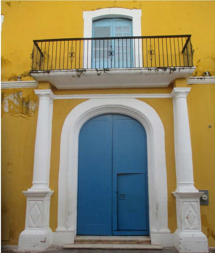
Figura 4. Fachada de la Casa de Teniente de Rey sobre la Calle 59.
