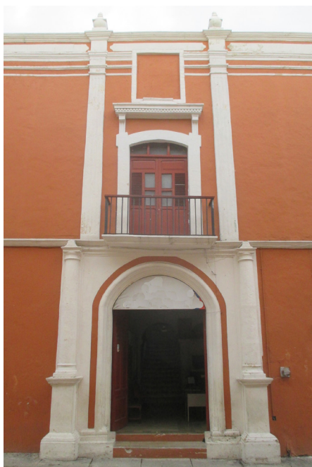
Figura 1. Fachada de la Casa de Teniente de Rey sobre la Calle 51.
