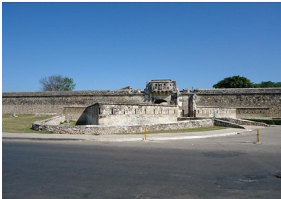
*Figura 7.- La Puerta de Tierra en la muralla de Campeche. En primer plano se observa el foso, el revellín y su acceso en uno de sus flancos.*
