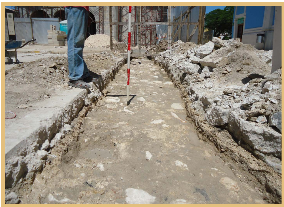
Antiguo nivel de pavimento de la calle 8 localizado frente a la fachada del baluarte de Nuestra Señora de la Soledad (Ojeda et al., 2015).
