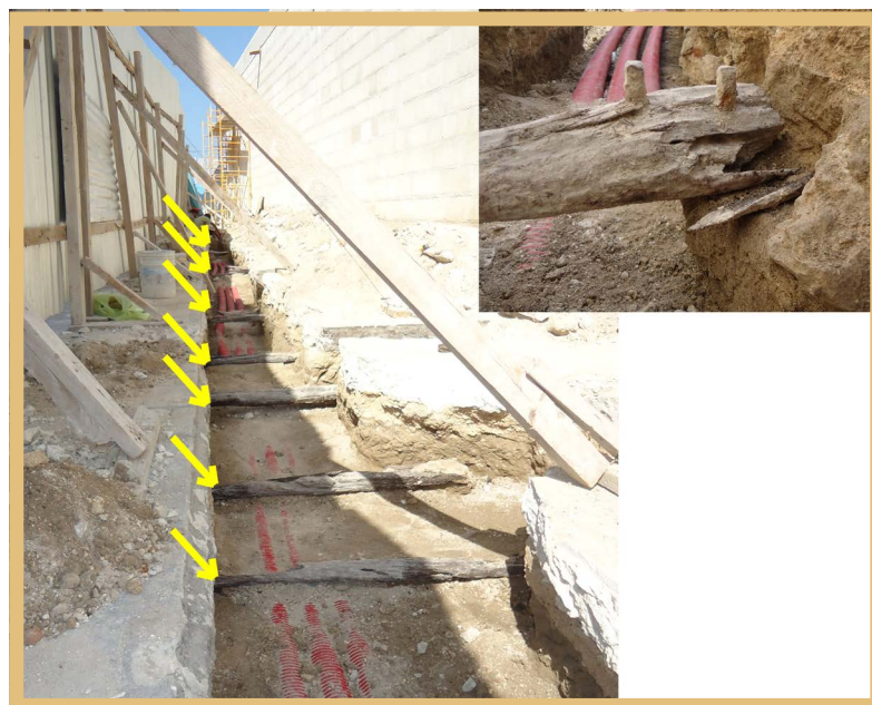
Vista general de los durmientes de madera y detalle con un par de clavos hallados in situ en la exploración de la cala 2 (Ojeda et al., 2015).
