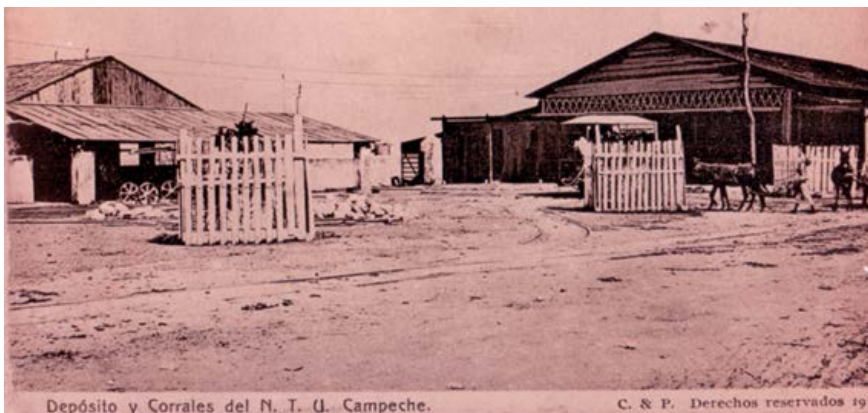
Foto 3. Depósito y corrales del Nuevo Tranvía Urbano de Campeche en 1910. Acervo fotográfico de Silvia Teresa Marcial Gutiérrez.
