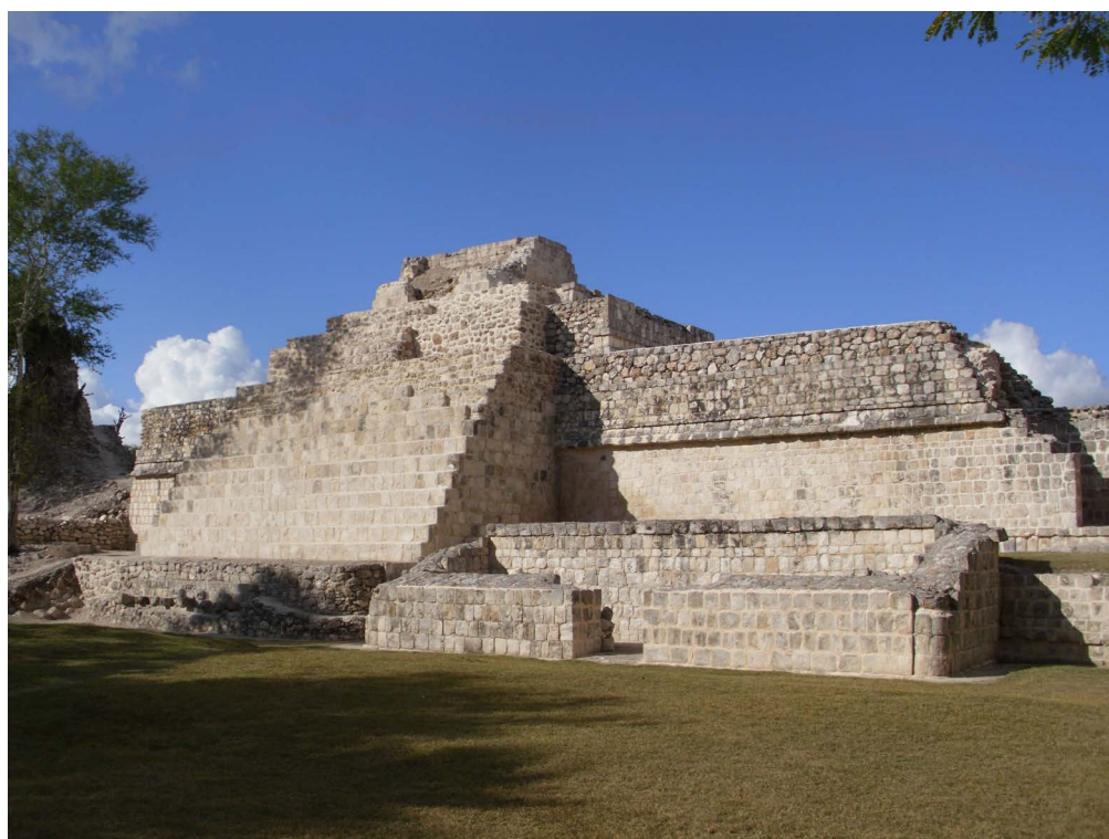
Costado sur de la torre central al concluir la restauración arquitectónica (Ojeda Mas et al. 2011).
