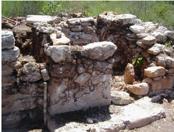
Foto 6. Mampostería con argamasa de kancab.
