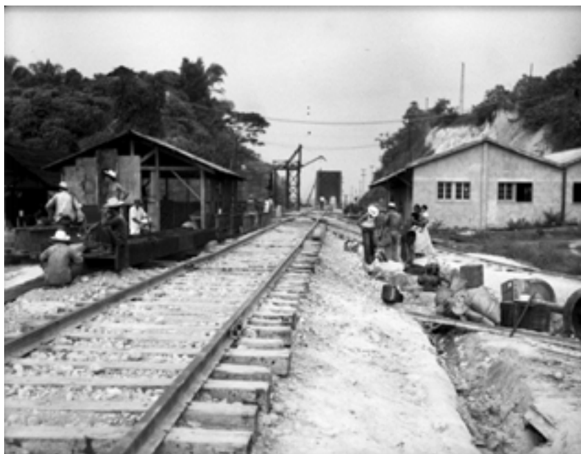
Trabajadores durante las obras de construcción de una estación ferroviaria en la línea del sureste. Circa 1950. INAH.
