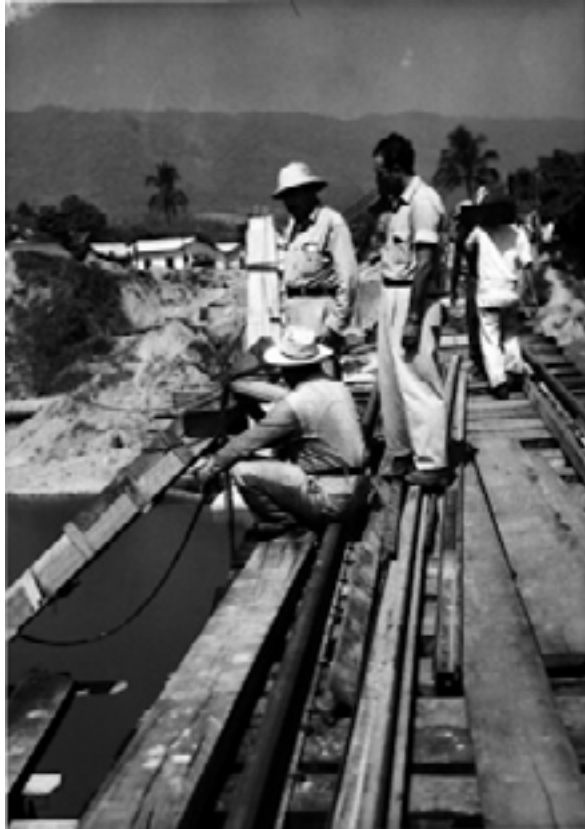
Ingeniero y trabajadores durante el tendido de vías en la construcción de un puente ferroviario en la línea del sureste.
