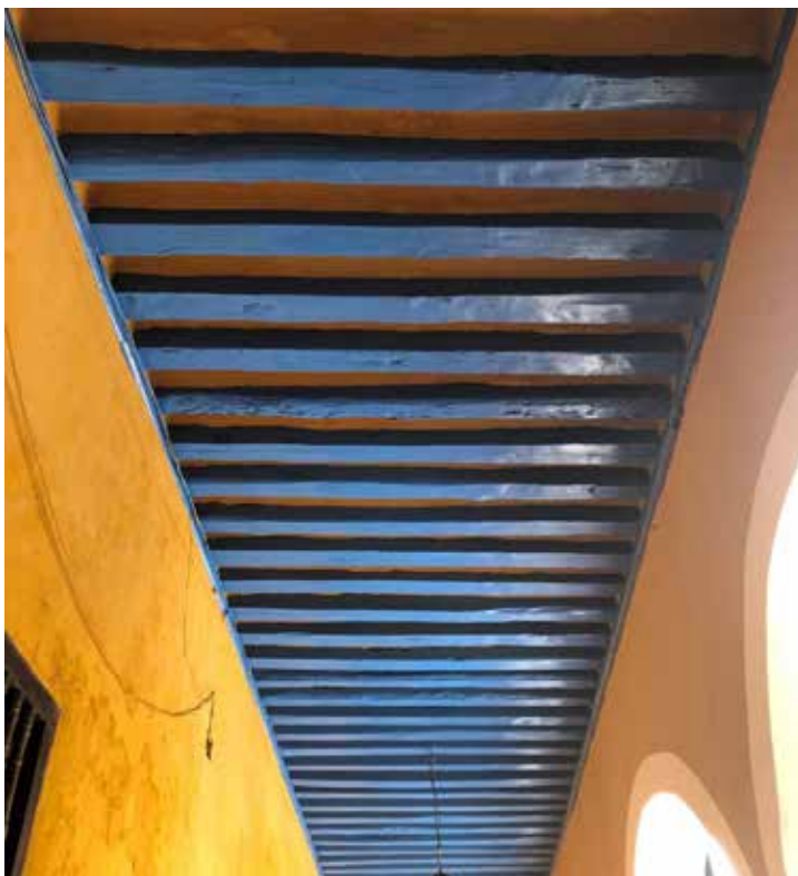
Sistema constructivo a base de viguetas de madera dura.
