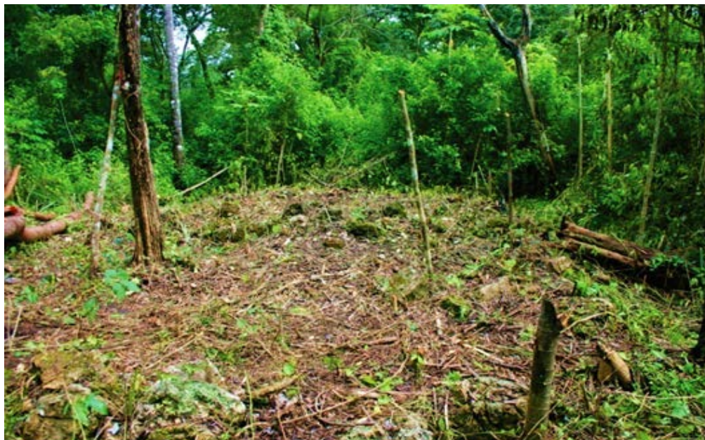
Figura 3. Estructura 4A, cimiento que se halló sobre la nivelación de 30 cm de altura, vista desde el norte.
