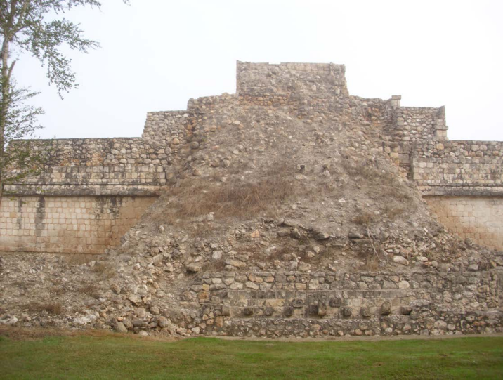
Condiciones del lado sur de la torre central antes de su excavación y restauración arquitectónica (Ojeda Mas et al. 2011).
