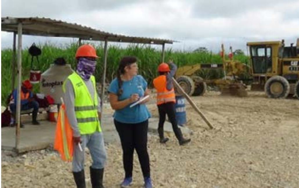
Joven trabajador entrevistado en la construcción del puente de Sergio Butrón Casas.
