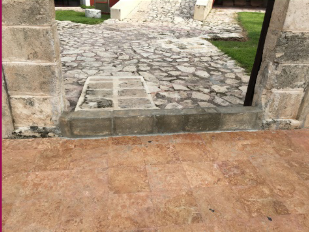
Se retiraron los pretilos y se colocaron rampas.
