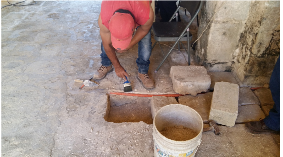
Instalación de energía eléctrica y colocación de crema maya.
