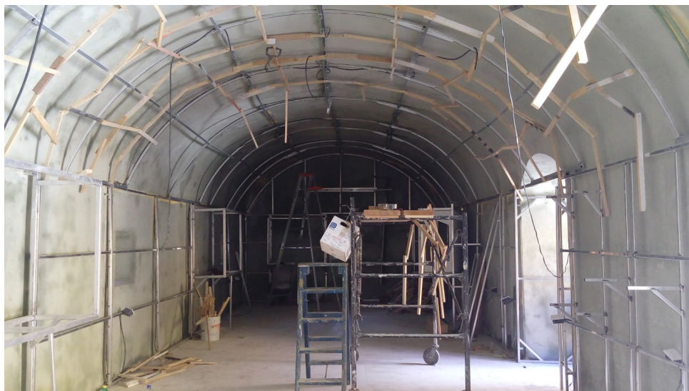
Avances de la colocación de una estructura para la recreación de la sala 2 y evitar afectaciones al edificio.
