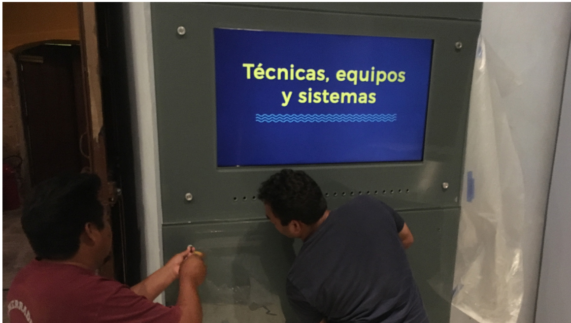
Colocación de pantallas táctiles.
