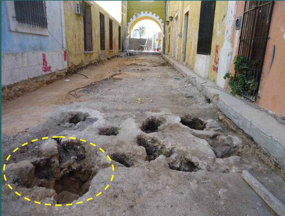
Ubicación de la oquedad donde se halló el entierro humano precolombino de la cultura maya en la calle Gómez Farías, en el barrio de San Francisco.
