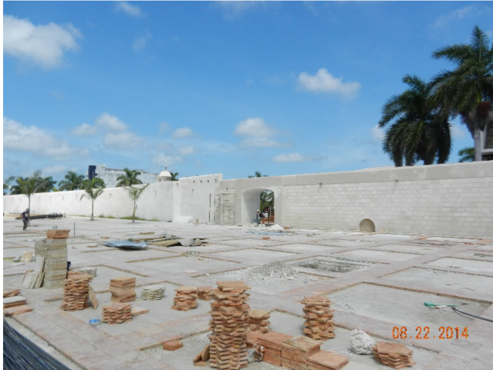
Restitución de muralla en la calle 8.
