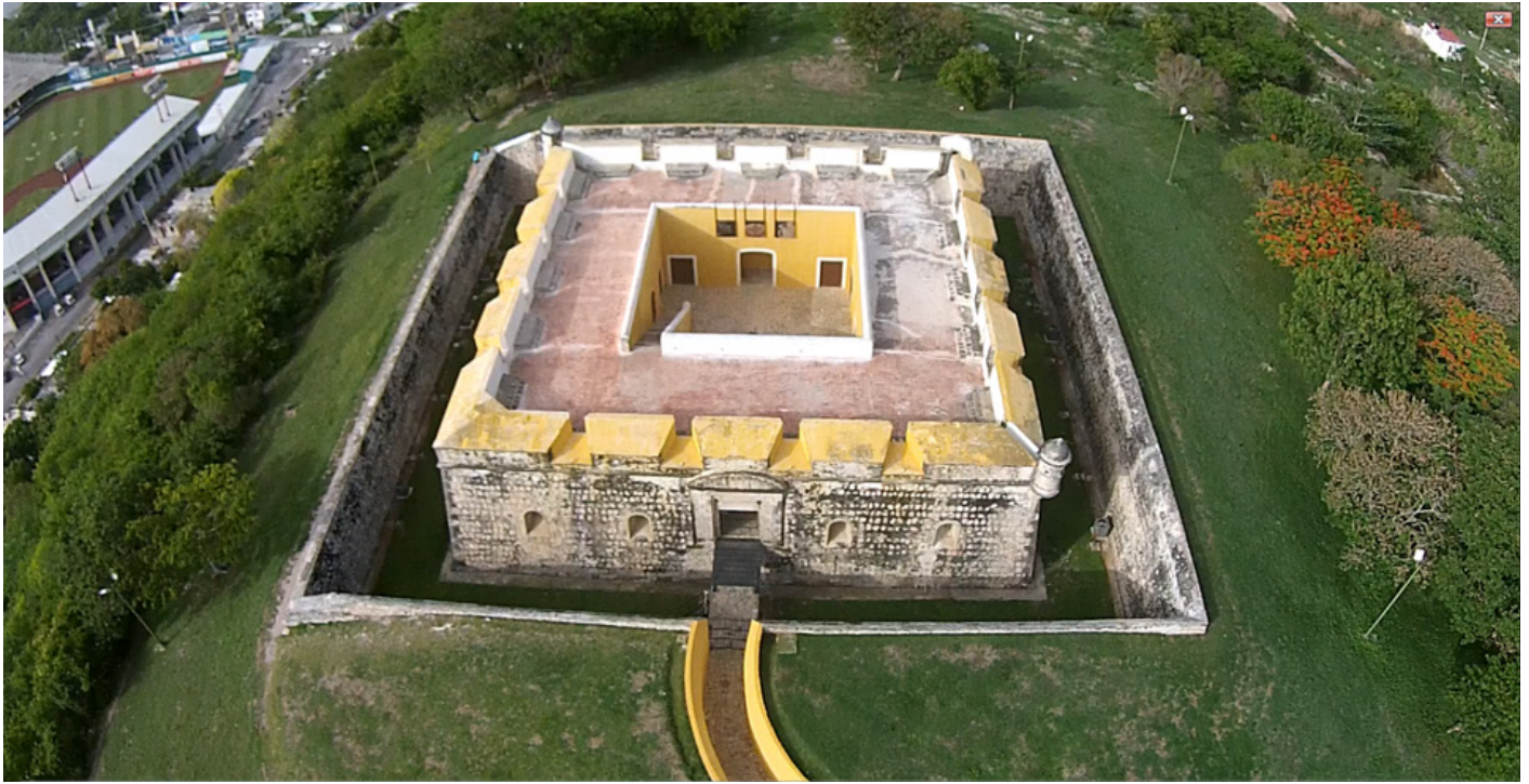
Vista aérea del reducto de San José el Alto.
