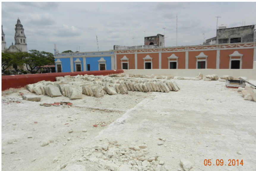
Sustitución de baldosas del adarve del baluarte de Nuestra Señora de la Soledad.
