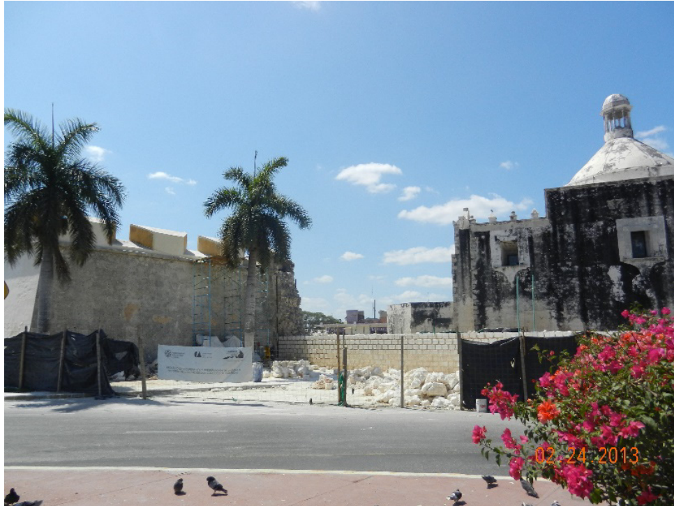
Restitución de muralla en el baluarte de San Pedro.
