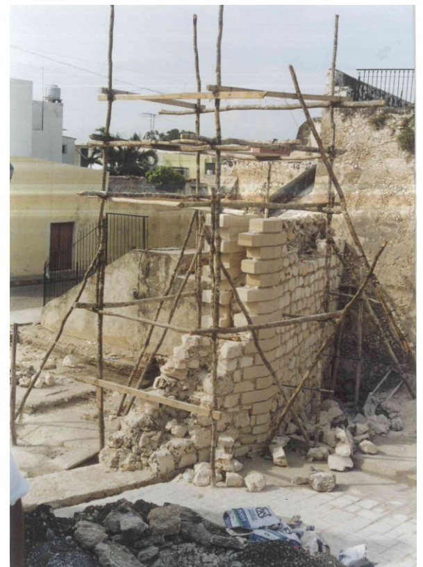
Sustitución de muralla en el baluarte de San Francisco.
