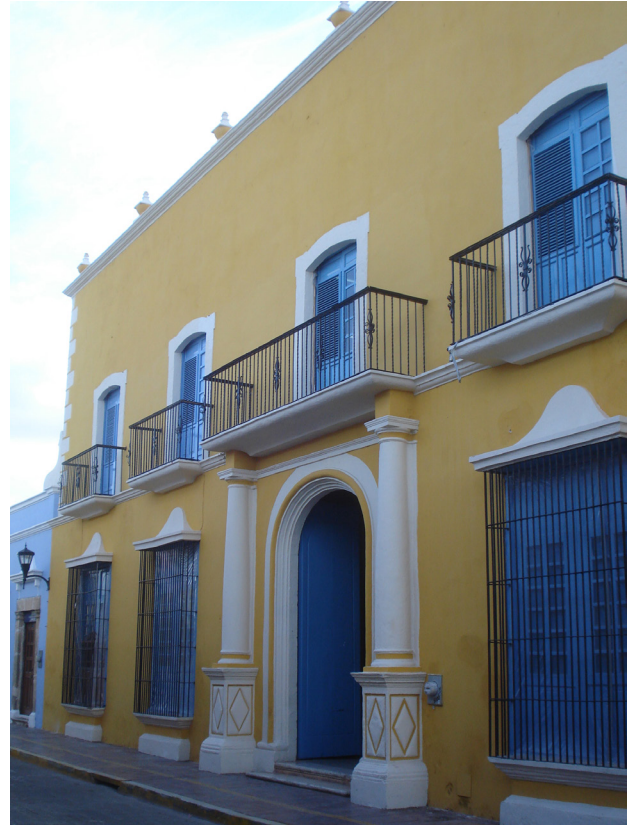
Figura 5. Vista general de la casa de Teniente de Rey de la Calle 59.
