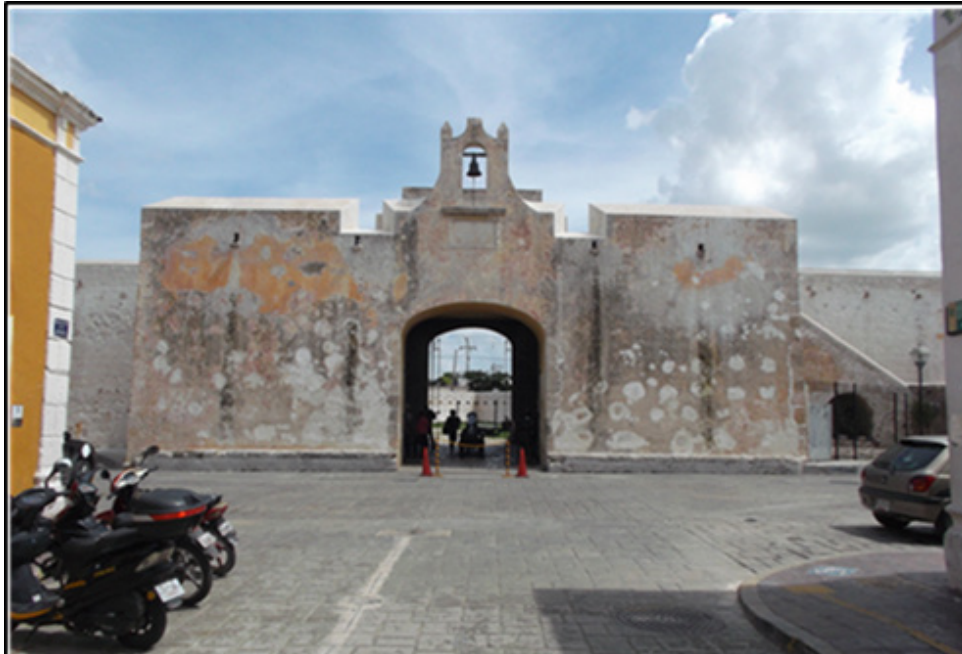
Figura 11.- Fachada de la Puerta de Tierra al interior del recinto amurallado de Campeche.
