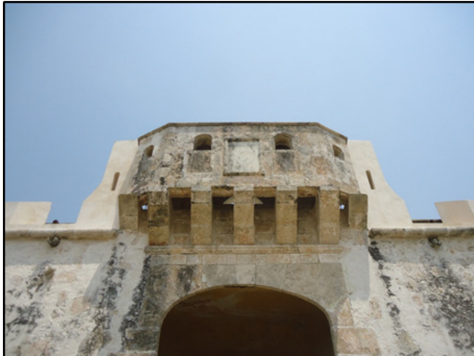
Figura 10.- Detalle del matacán donde se arrojaban granadas de fuego.
