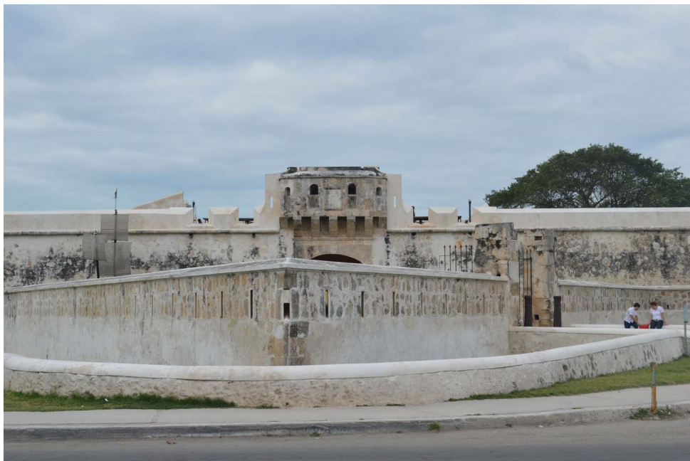
Puerta de Tierra, construida en 1732
