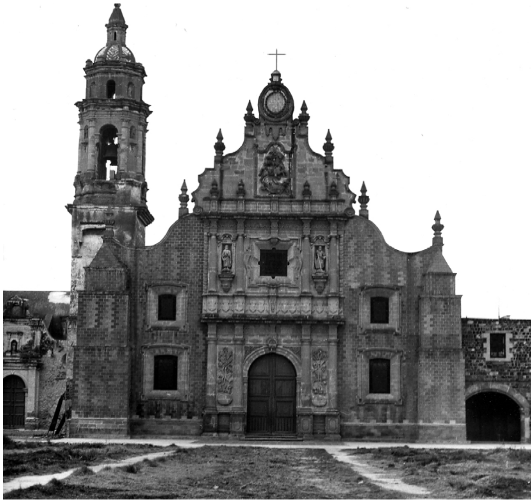
Vista general de la fachada desde el atrio, Chalco, Estado de México, fotógrafo E. Sánchez.
