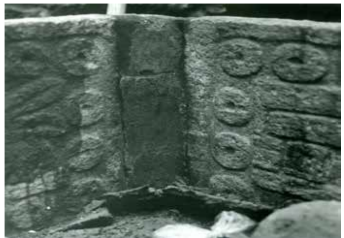
► Fig. 9 Reparación de faltante de una esquina. CALLE_DE JOSÉ_MA._IZAZAGA_Y_PINO_SUÁREZ_D.F. LVI-A-13-1-2. Antonio Reynoso. Fototeca CNCPC |© INAH, 1970.
