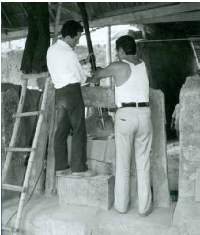
► Fig. 8 Sergio Arturo Montero introduciendo el soporte en el interior de la estructura, se observa parte metálica que penetró el interior de la estructura del altar para evitar pandeo. ZAPOTAL_AD-1_VERACRUZ. LII-22-5-6. Alicia Islas. Fototeca CNCPC |© INAH, 1974.
