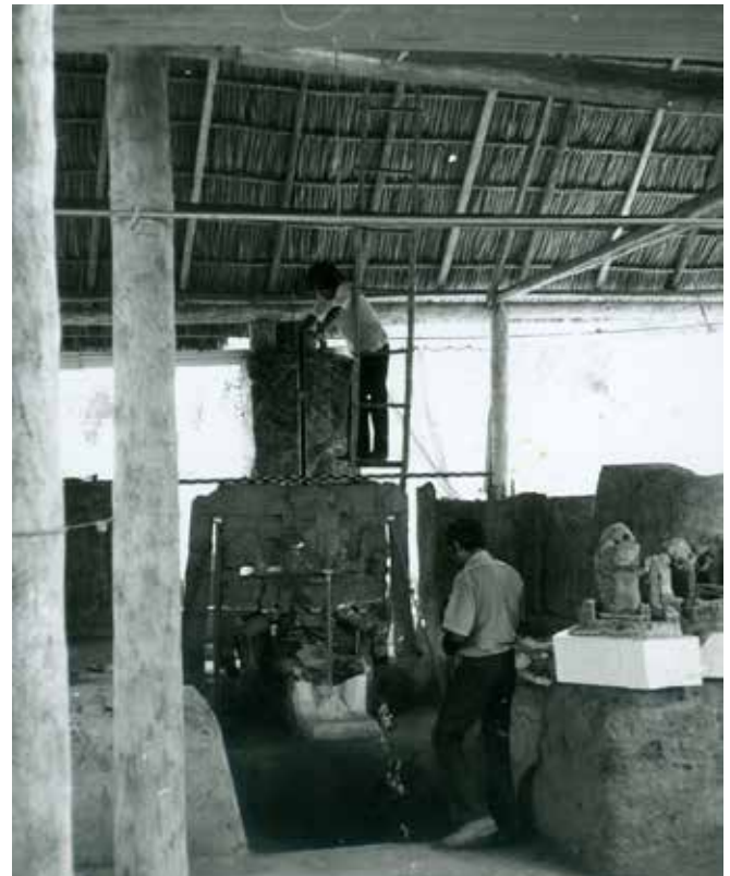
► Fig. 9 Introducción de soporte vertical para evitar la inclinación de la estructura. Se observan apuntalamientos sosteniendo tocado y extremos durante la operación. En ese momento el altar se encontraba cubierto por una palapa sencilla de madera y protegido lateralmente con sencillas cortinas. ZAPOTAL_AD-1_VERACRUZ. LII-22-5-1. Alicia Islas. Fototeca CNCPC |© INAH, 1974.
