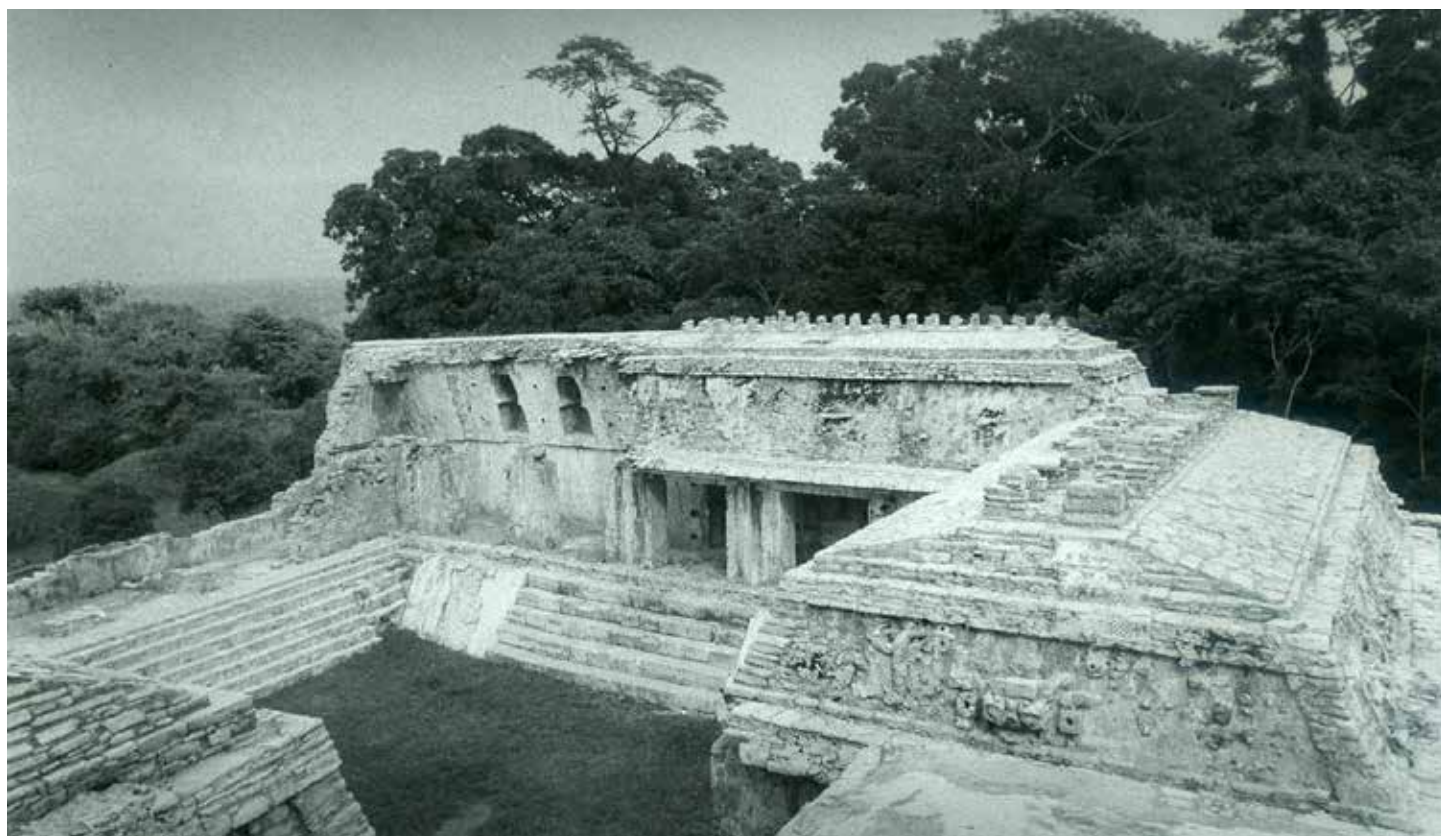
► Fig. 5 Palenque Chiapas, Palacio (edificios A y B) foto tomada un año después de la aplicación de biocidas. Fototeca CNCPC |© INAH, 1974.
