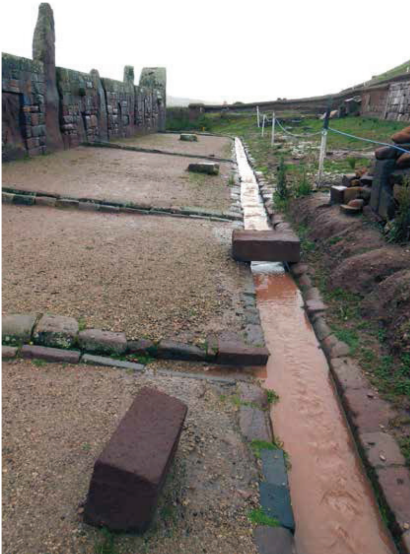
Rehabilitación de salidas de agua como medida de protección. Conducción de aguas pluviales precolombina en Tiwanaku, Bolivia. 2014.
