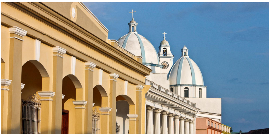
Cúpulas Parroquia de San Cristóbal. Fotografía: ©Carmen Priego Medina.
