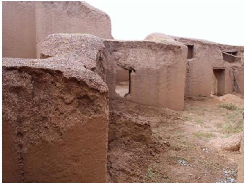
Fig. 05. Deterioro provocado por lluvia. Foto de archivo, Proyecto Arqueológico Paquimé 2018.
