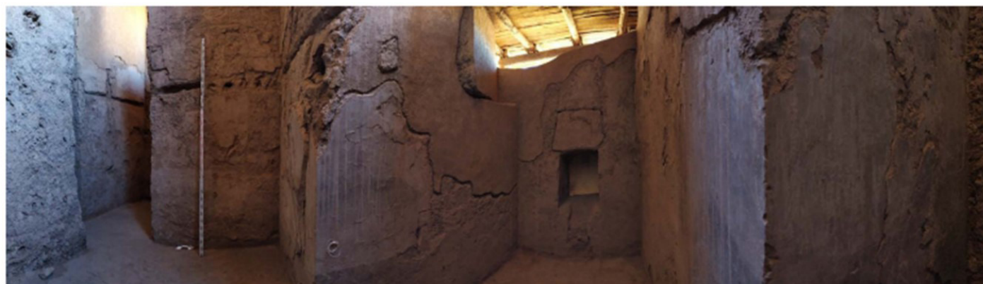
Fig. 11. Cuarto 45 Casa de Los Pilares, interior. Después de las intervenciones de restauración. imagen de Archivo PAP, 2021.
