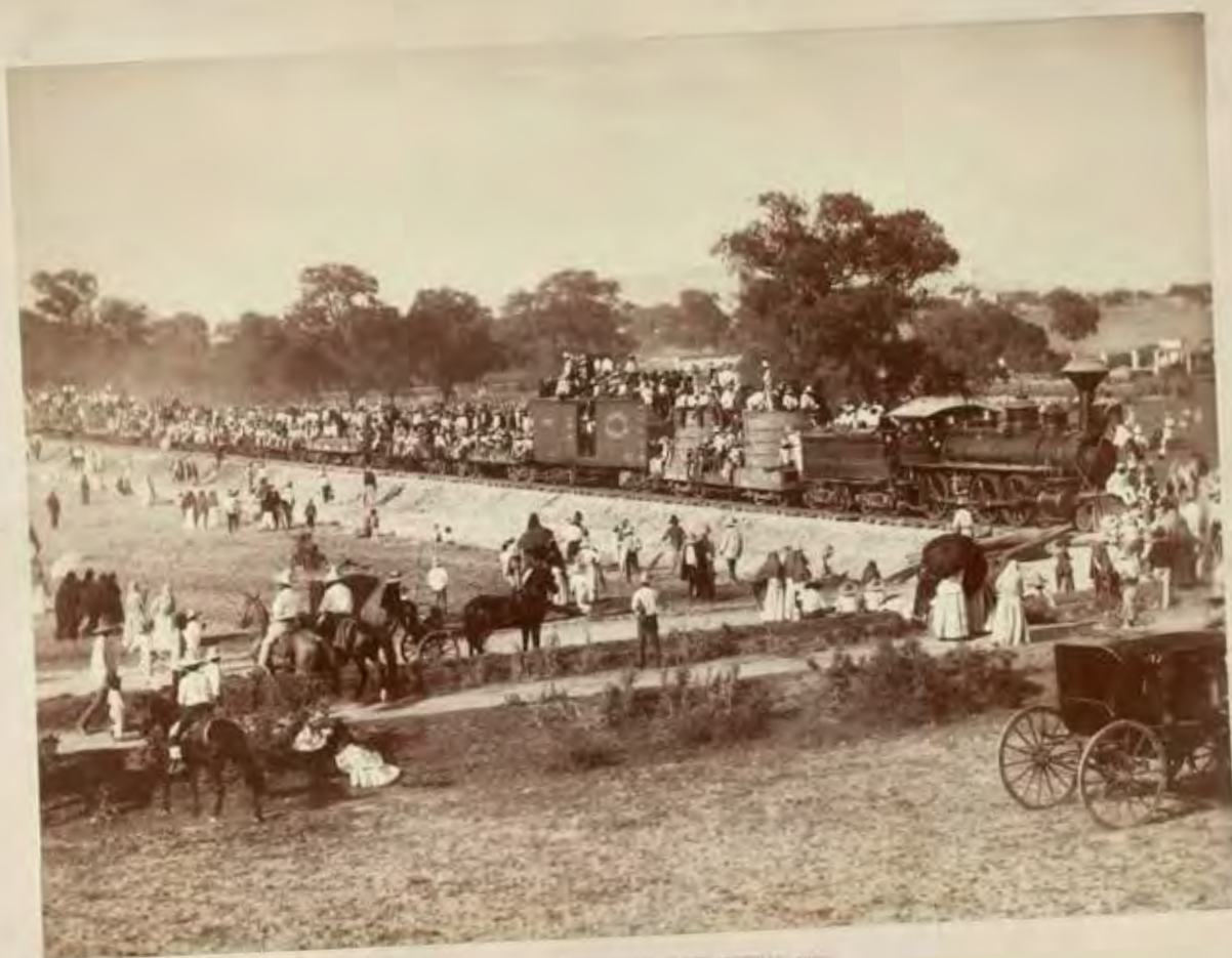
Estado de Colima. (México.)
