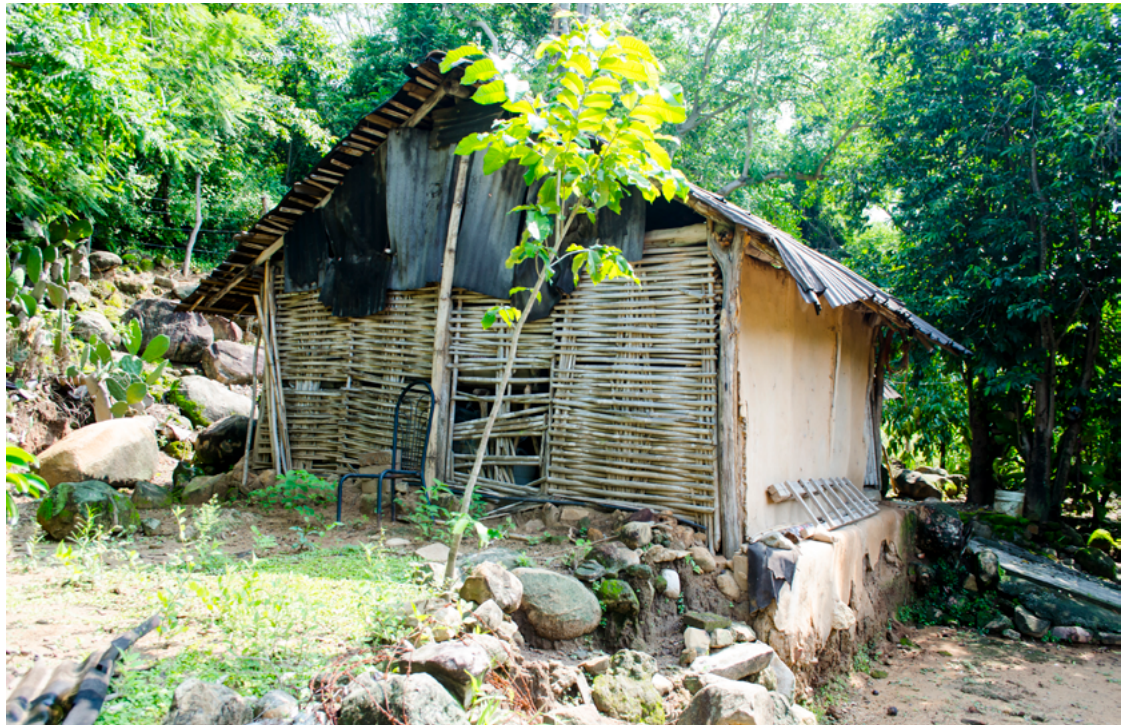
FIGURA 7. Vivienda de pajarete ubicada en la comunidad de Pueblo Nuevo, en la cual se pueden apreciar los muros entreverados de otate y la presencia y ausencia de tierra como acabado (Fotografía: Antonio Flores, 2016).
