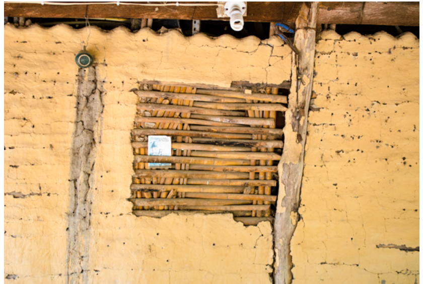
FIGURA 8. Detalle del tipo de ventana utilizado en la vivienda de pajarete que se encuentra en la zona Valle del estado de Colima (Fotografía: Antonio Flores, 2016).
