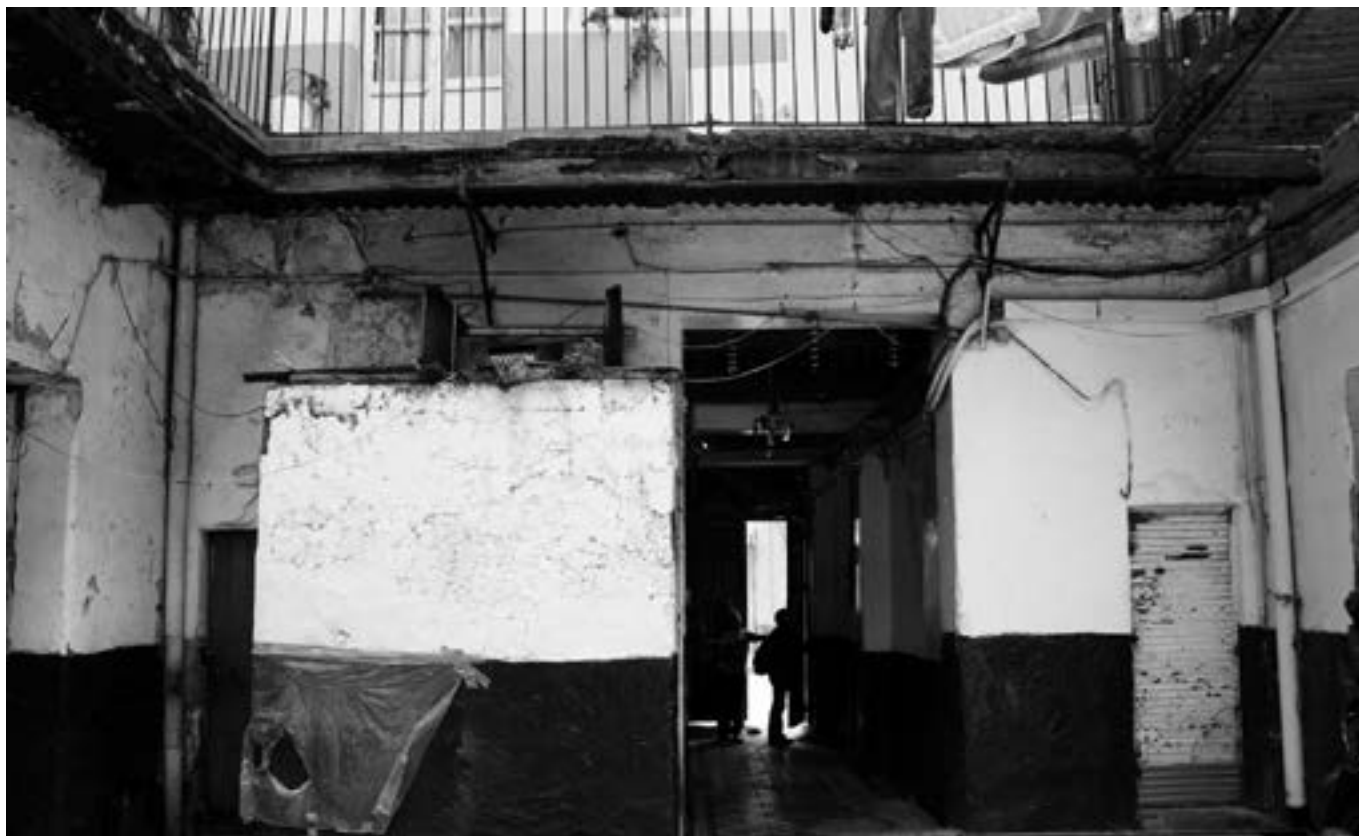
FIGURA 10. Detalle de los baños agregados en el patio central de República de Cuba núm. 32. Vista interior hacia el acceso principal (Fotografía: Patricia Sánchez, 2017).
