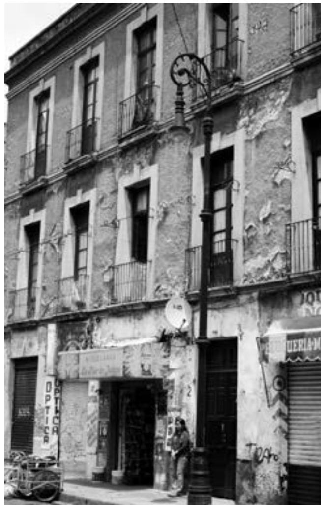
FIGURA 9. Vista de las accesorias en planta baja en fachada de República de Cuba núm. 32 (Fotografía: Patricia Sánchez, 2017).
