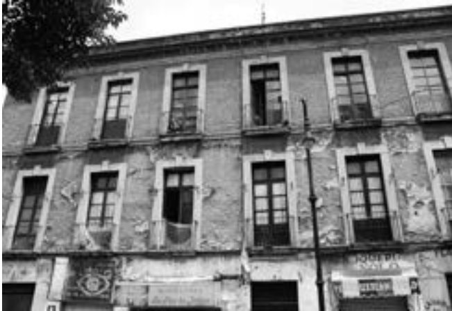
FIGURA 4. Fachada principal de República de Cuba núm. 32 (Fotografía: Patricia Sánchez, 2017).
