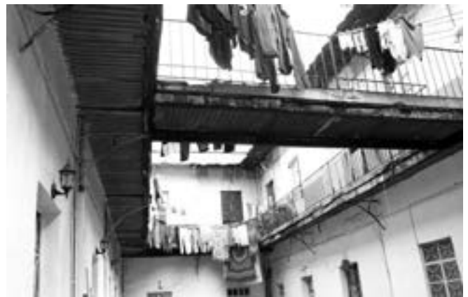
FIGURA 6. Sistema de andadores de viga y lámina de metal al interior de República de Cuba núm. 32 (Fotografía: Patricia Sánchez, 2017).
