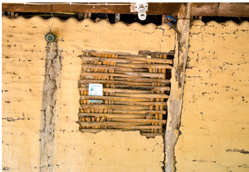
FIGURA 8. Detalle del tipo de ventana utilizado en la vivienda de pajarete que se encuentra en la zona Valle del estado de Colima (Fotografía: Antonio Flores, 2016).
