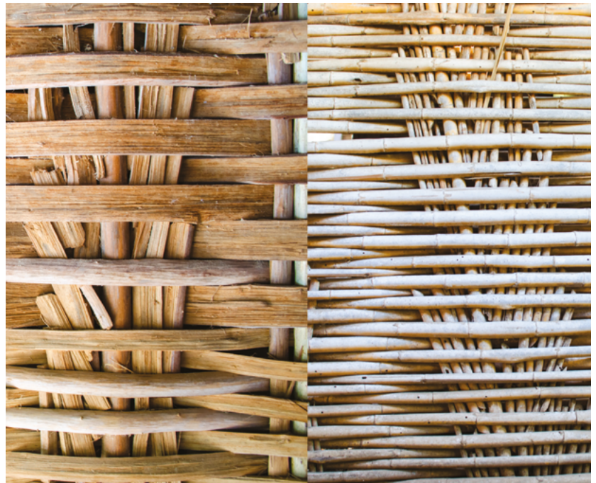
FIGURA 6. Comparación de dos materiales utilizados para el entramado de muros de pajarete. Izquierda: muro entreverado con majagua; derecha: muro entreverado con otate abierto (rajado) (Fotografía: Antonio Flores, 2018).
