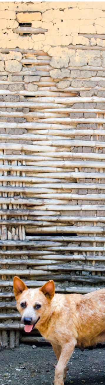
FIGURA 7. Vivienda de pajarete ubicada en la comunidad de Pueblo Nuevo, en la cual se pueden apreciar los muros entreverados de otate y la presencia y ausencia de tierra como acabado (Fotografía: Antonio Flores, 2016).
