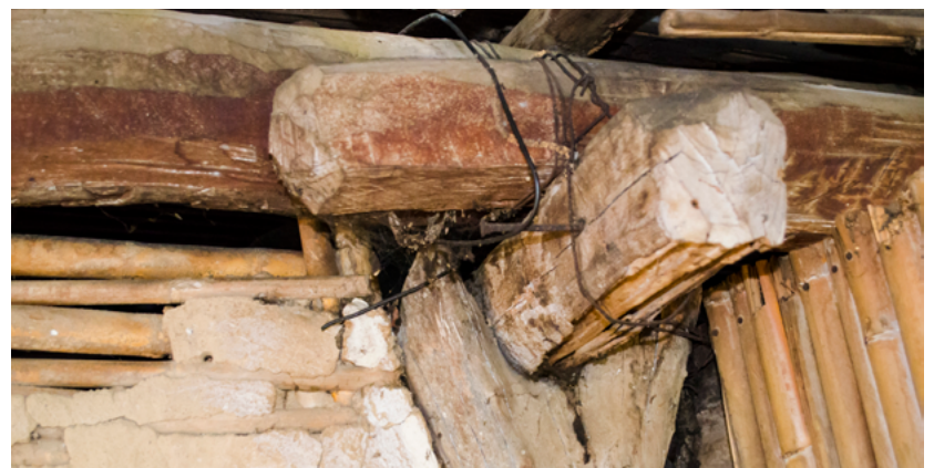
FIGURA 5. Detalle de soleras hincadas sobre horcones de la estructura vertical y amarres de alambre (Fotografía: Antonio Flores, 2016).
