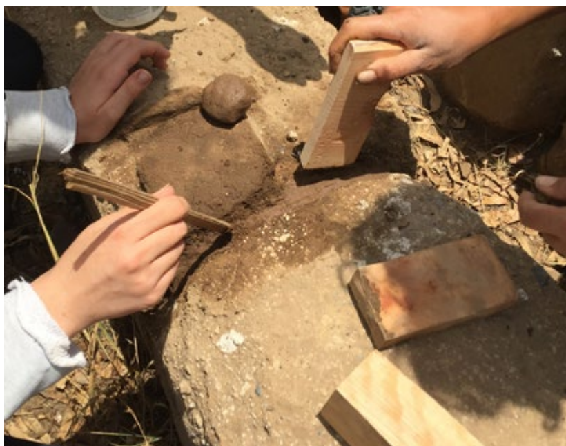
FIGURA 10. Relleno de grietas durante un taller del Programa de Inmersión en la Bioconstrucción. Proyecto San Isidro, Tlaxco, Tlaxcala, México (Fotografía: Luis Fernando Guerrero Baca, 2019).
