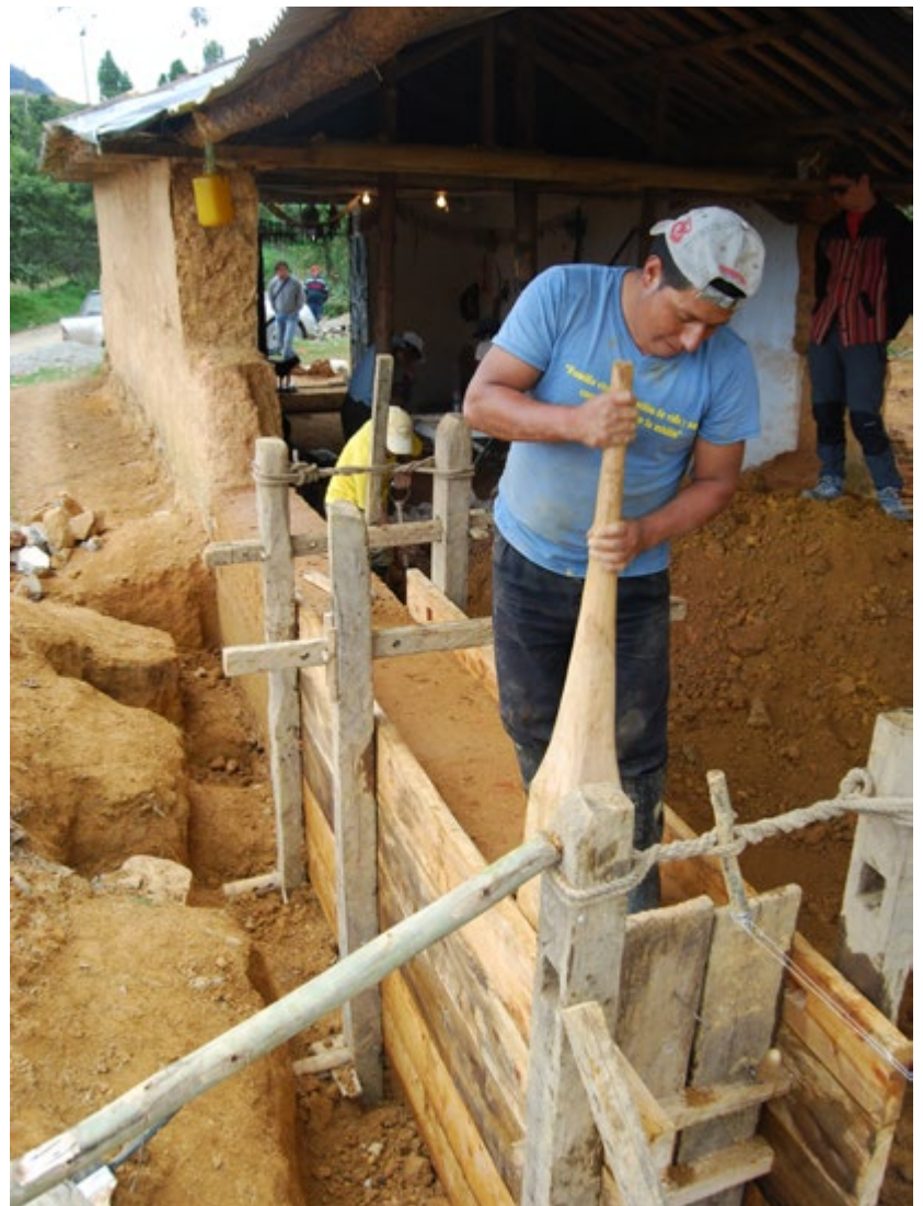
FIGURA 7. Restauración de una capilla patrimonial de tapia en Chuquiribamba, Ecuador (Fotografía: Luis Fernando Guerrero Baca, 2014).
