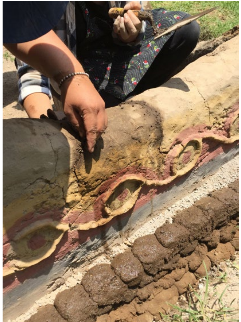
FIGURA 12. Práctica de consolidación y reenterramiento usando tierra modelada en las clases de la Maestría en Conservación y Restauración de Bienes Culturales Inmuebles de la ENCRYM-INAH (Fotografía: Luis Fernando Guerrero Baca, 2019).
