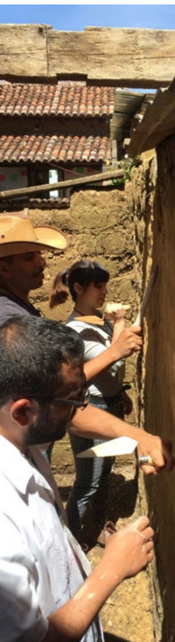
FIGURA 10. Relleno de grietas durante un taller del Programa de Inmersión en la Bioconstrucción. Proyecto San Isidro, Tlaxco, Tlaxcala, México (Fotografía: Luis Fernando Guerrero Baca, 2019).
