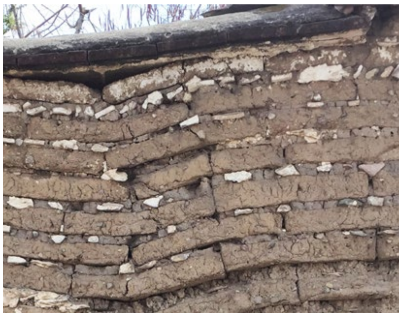
FIGURA 9. Los adobes, a diferencia de otros mampuestos, tienen la capacidad de deformarse dentro de ciertos límites. Huehuatlán El Chico, Puebla, México (Fotografía: Luis Fernando Guerrero Baca, 2018).
