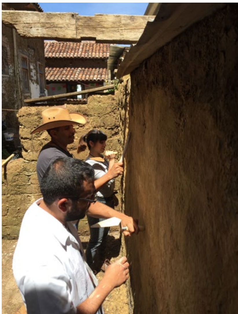
FIGURA 2. Restauración de un muro de adobe durante el curso-taller para conservadores del Centro INAH Chiapas. San Cristóbal de Las Casas, México (Fotografía: Luis Fernando Guerrero Baca, 2018).
