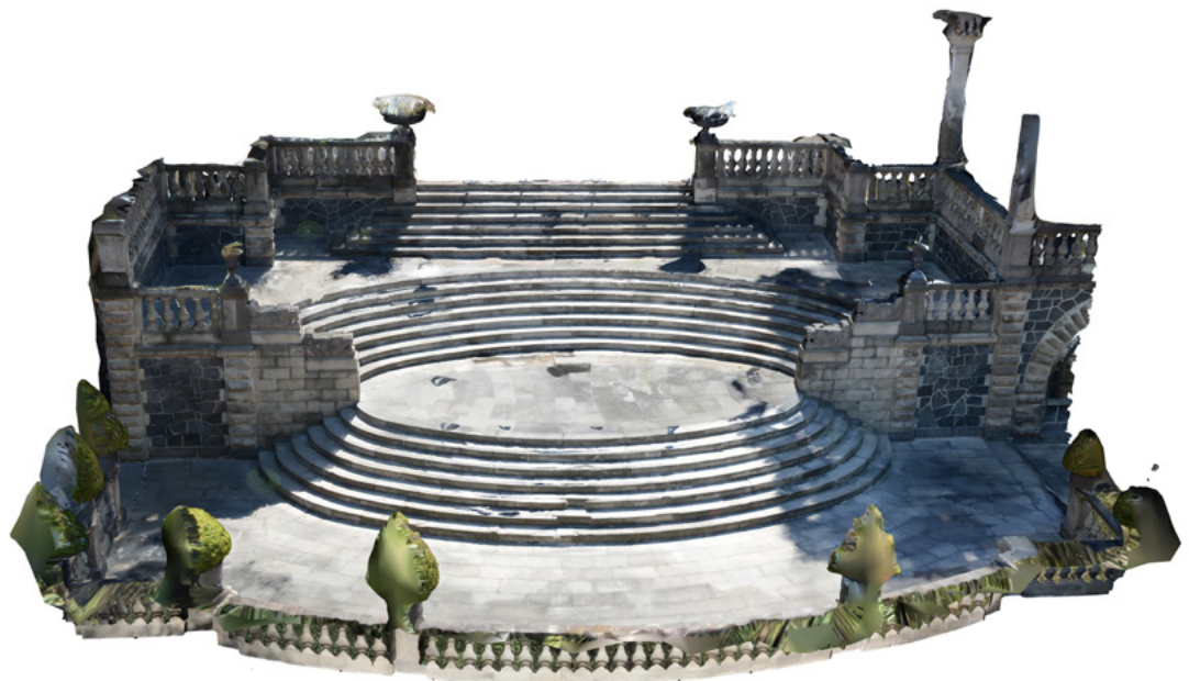
FIGURA 4. Escalinata del Jardín de las Pérgolas , MNH. Modelo tridimensional elaborado por fotogrametría digital (Levantamiento y elaboración del modelo: Áyax Horacio Segura Galván, 14 de enero de 2023; cortesía: Museo Nacional de Historia, CNMH).
