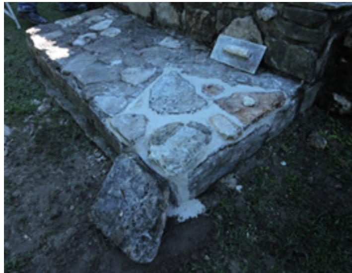
Trabajos de mantenimiento de los elementos decorativos enterrados
