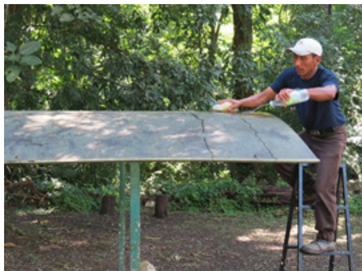
Limpieza de techos de protección
