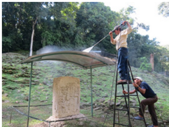
Limpieza de techos de protección
