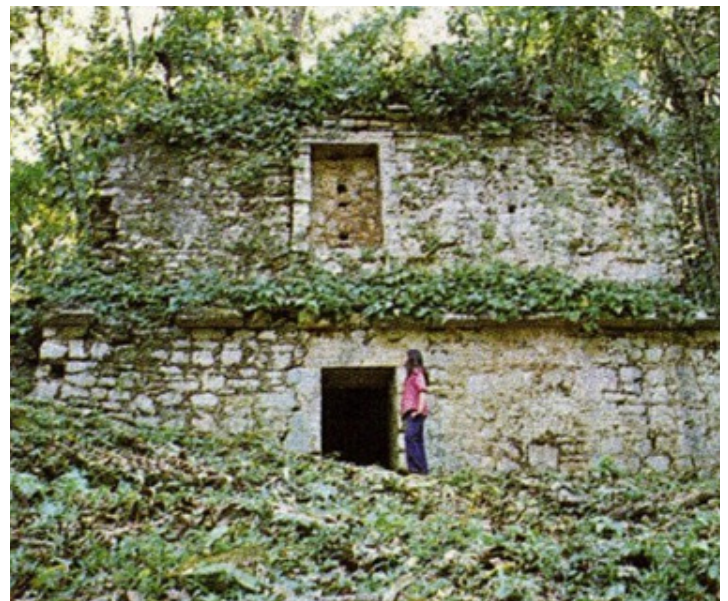
Edificio 21 antes de ser excavado (foto 1970)
