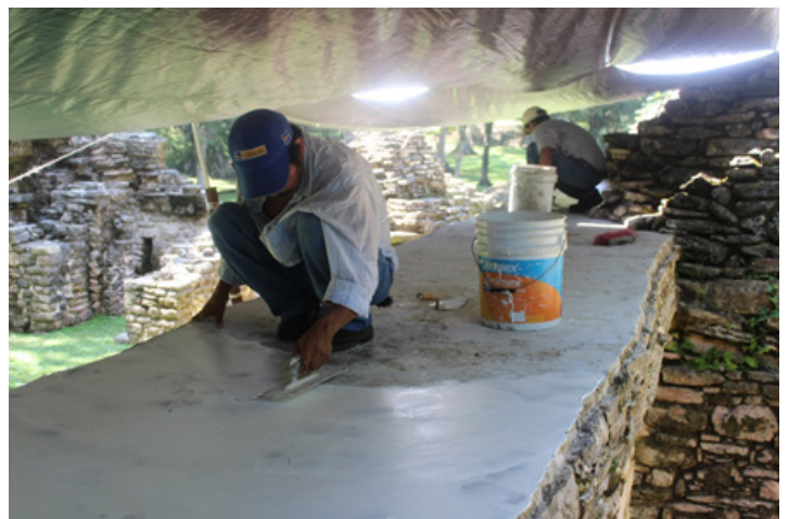
Trabajos de mantenimiento en techos (impermeabilización con cal) (Foto temporada 2015)
