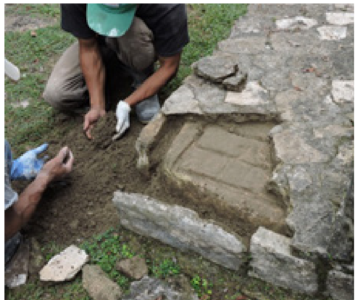
Trabajos de mantenimiento de los elementos decorativos enterrados
