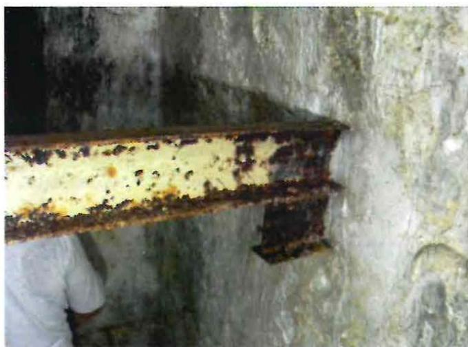
Foto 5. Vigas de hierro con avanzado estado de oxidación
