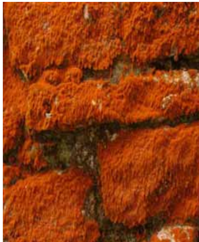
Figura 2. Crecimiento de algas sobre un muro ( Trentepohlia aurea ).
