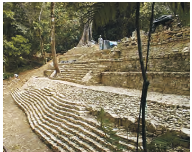
Detalle arquitectónico del exterior del Edificio XIX.
