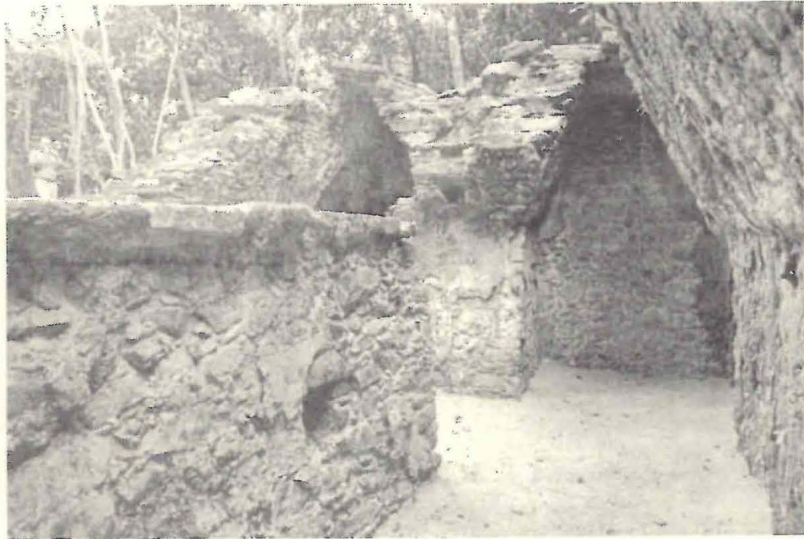
Aspecto de las galerías del Templo XXII. Una tarea prioritaria dentro de los trabajos del PAP fue la estabilización y consolidación de muros y bóvedas que se encontraban en riesgo de colapsarse.
